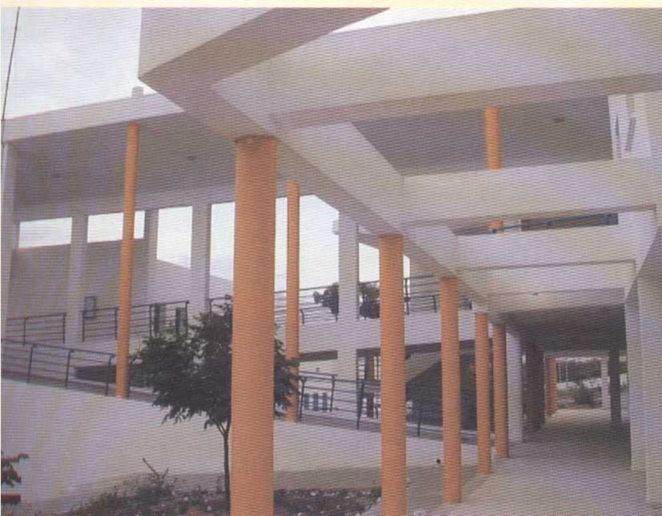
Vue sur les rampes à partir de l'une des galeries du rez de chaussée
