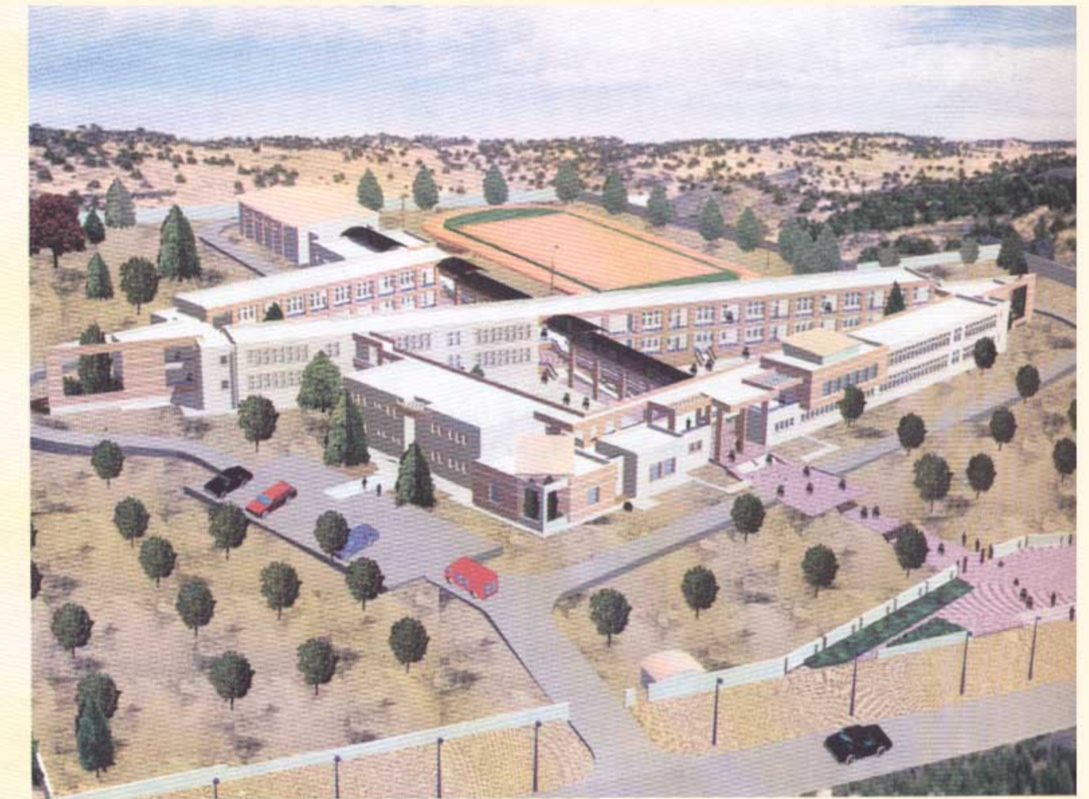
Lycée de Korba 2001-2002. Architecte : M'Hamed BEN AYED
